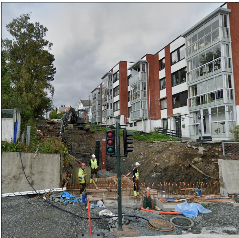
Figur 4-1: Bilde fra anleggsgjennomføring i prosjektets etappe 1
