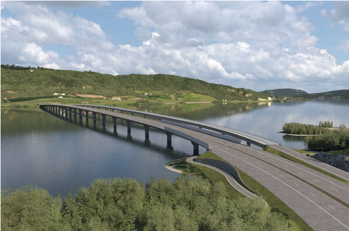
Figur 7-15: Eksisterende E6-bru til høyre, og ny Mjøsbru i alternativ 1 til venstre. Kilde: COWI AS
