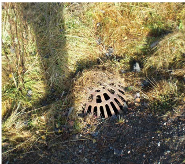
Figur: Manglende rensk rundt kuppelrist reduserer ristas kapasitet.
