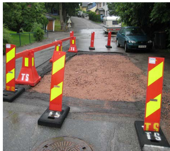
Figur: Sikring av gravested
