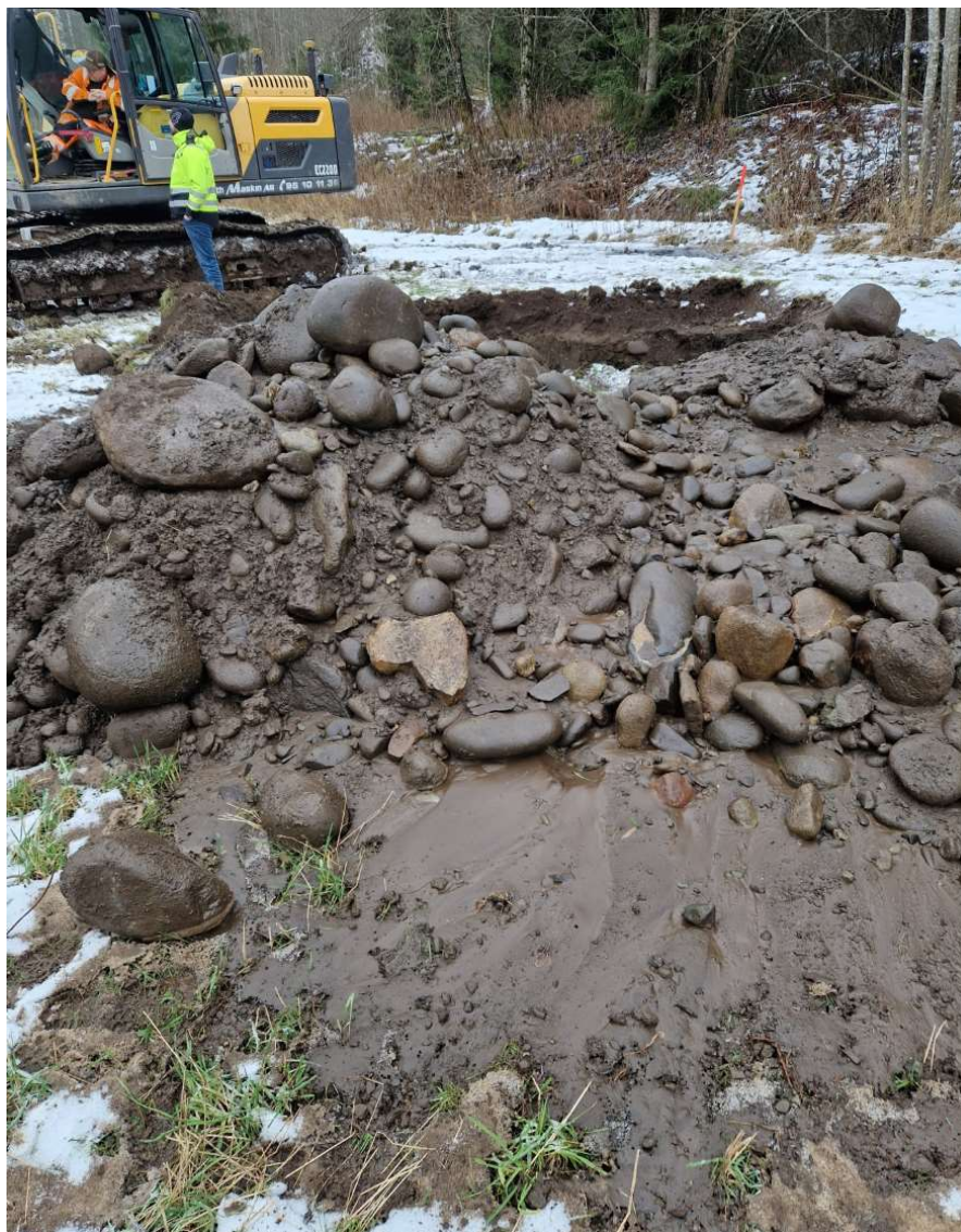
Figur 15 : Bilde viser gravemasser fra nedre del av prøvegrøp ved borpunkt 29
