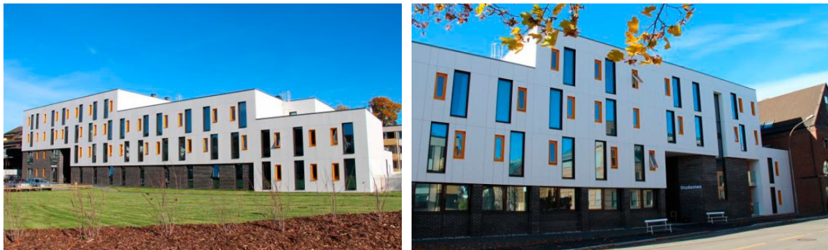
Figur 1 og 2, Studenten byggetrinn 1.
