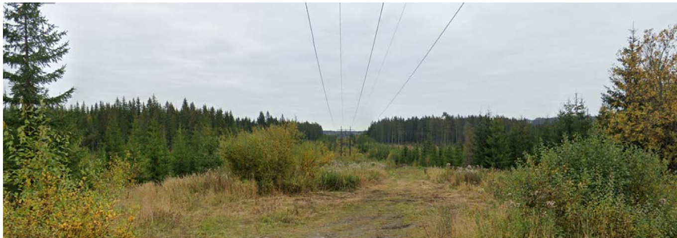
Figur 7: Høyspentkabel 66 kV igjennom området – sett fra vest.
