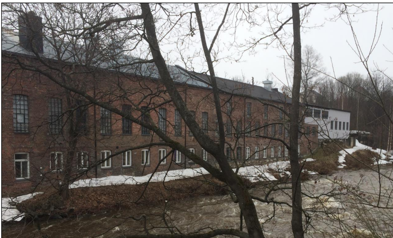
Figur 24 Gjøvik støperi sett fra bruene i Niels Ødegaards gate. Bilde fra befaring 20. april 2018.
