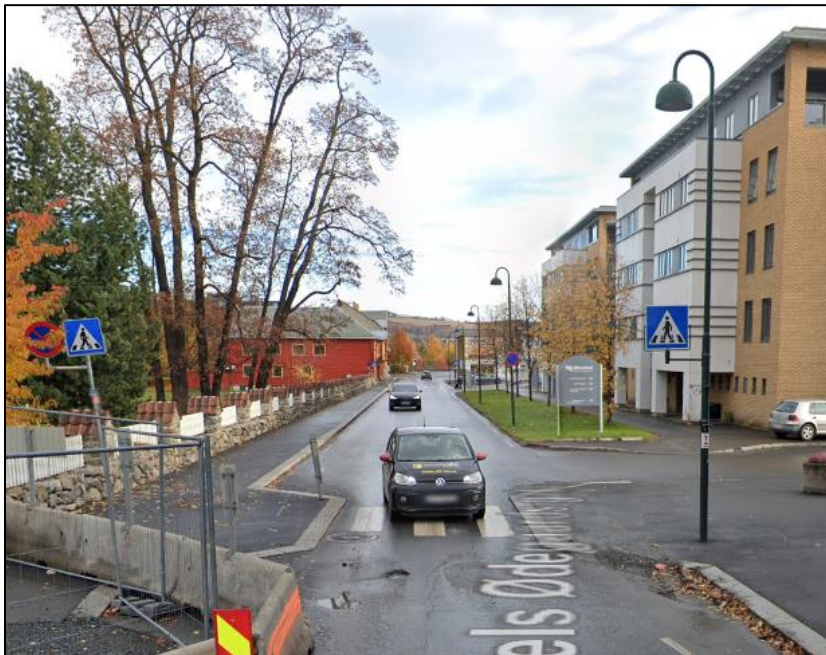
Figur 1.3 – Innsnevring av kjørebanen ved avkjørsel til Mustadhagen
