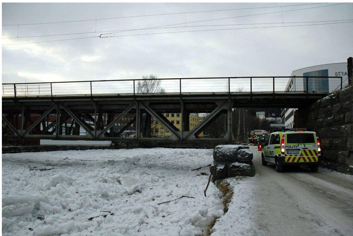
Figur 35 Jernbanebrua (under isgangen desember 2012) sett fra nedstrøms (Øyvind Lien, Oppland arbeiderblad, 2012)
