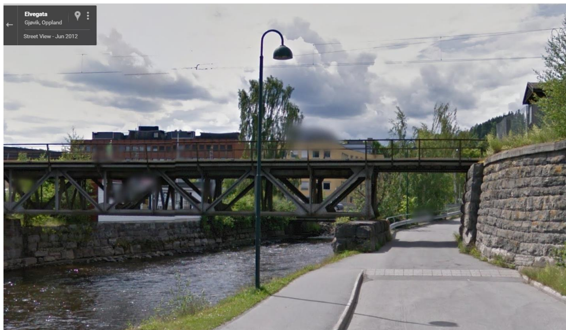
Figur 34 Jernbanebrua sett fra nedstrøms (normalsituasjon) (Google Streetview, juni 2012)
