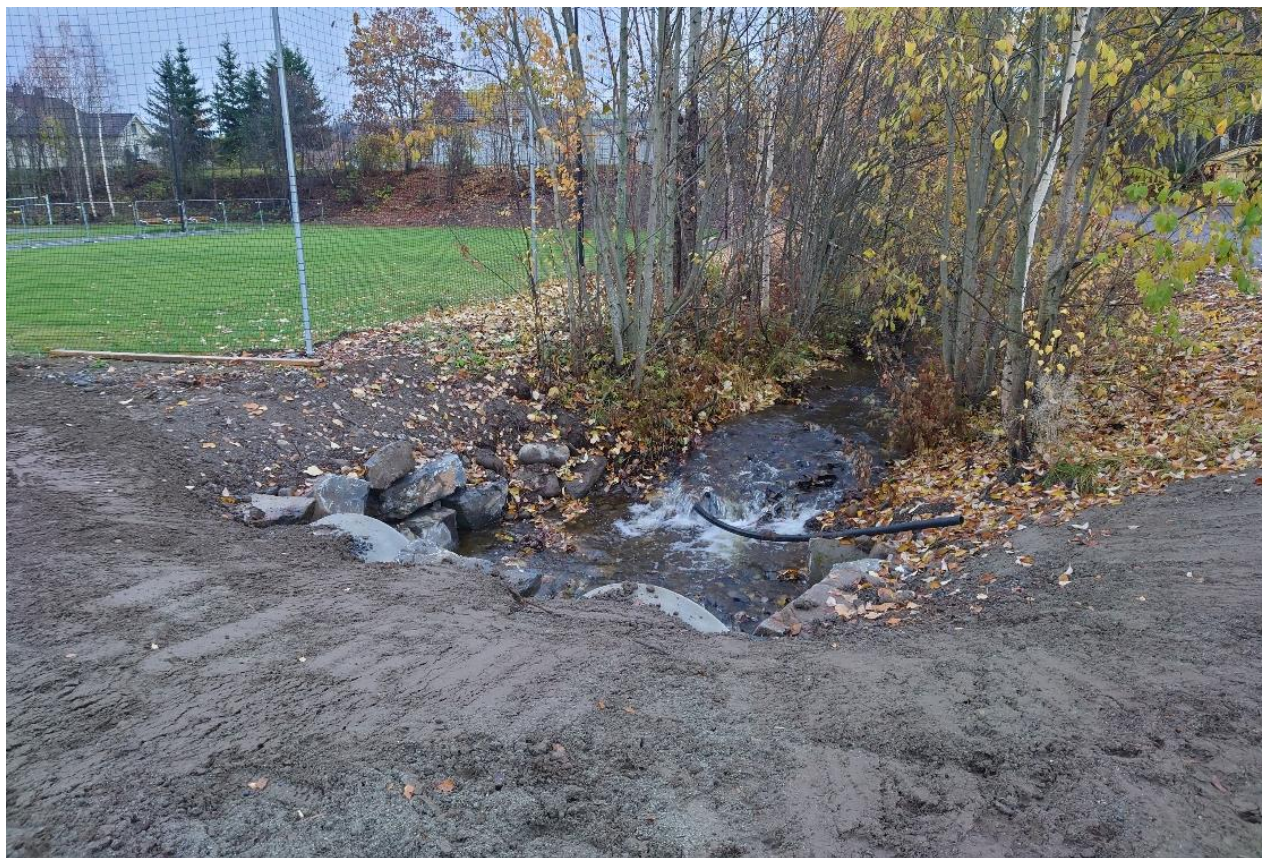
Figur 2: Sett oppstrøms ved innløpet av stikkrenner for Brynestadbergbekken gjennom Kragebergvegen (POI-ID 102).
