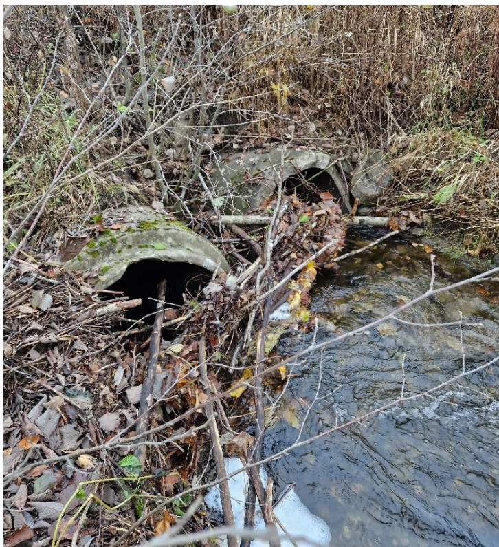
Figur 5: Innløp av stikkrenner nedstrøms der Kragebergbekken og Brynestadbergbekken møtes (POI-ID 101).
