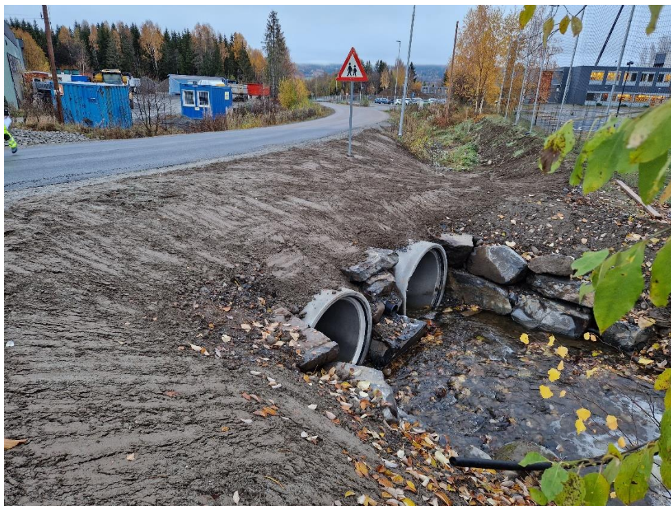
Figur 3: Innløp av nye kulverter for Brynstadbergbekken vest for Biri ungdomsskole (102)
