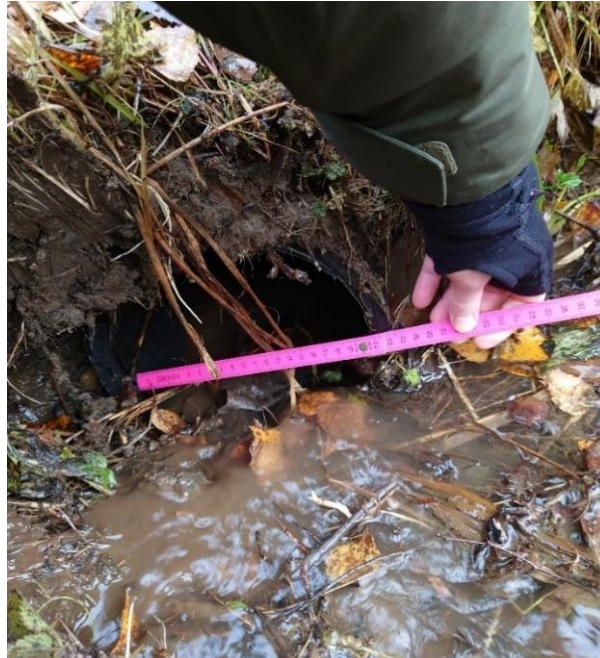
Figur 16: Eksisterende stikkrenne gjennom traktorvegen vest i planområdet, for den lille bekken. Stikkrenna må oppdimensjoneres for å håndtere flom.
