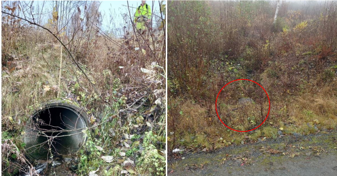
Figur 12: Tv. Innløp på Lundebekkens østre løp gjennom Kragebergvegen (1000 mm). T.h. innløp på Lundebekkens vestre løp gjennom Kragebergvegen (600 mm), sett oppstrøms fra veien.
