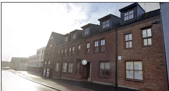
Figur 29, Eksisterende bebyggelse innenfor BKB3
