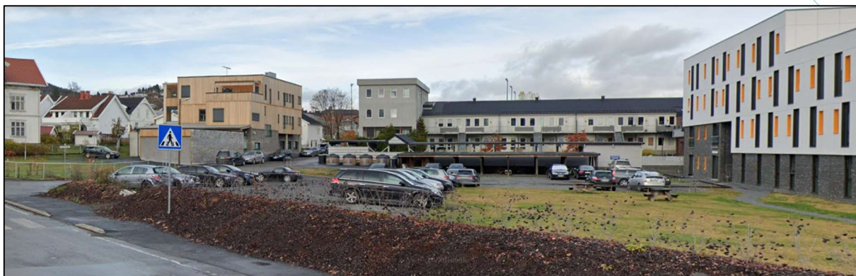
Figur 17, Etablert midlertidig gårds plass i tilknytning til Studenten byggetrinn 1
