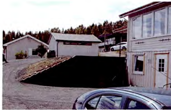
Bildet viser at det er helling mot boligen
