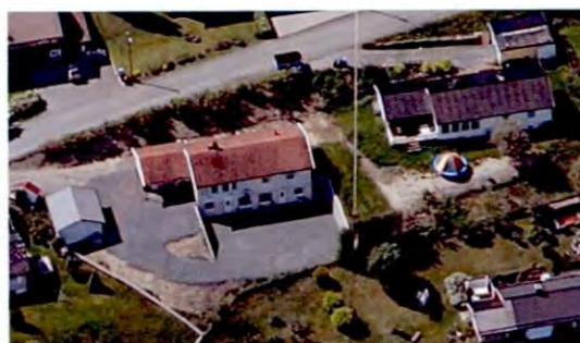
Sommer 2014. Underetasjen er ferdig etablert med to leiligheter.
