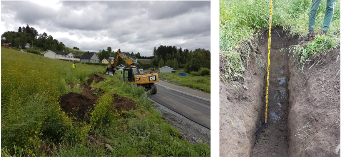
Figur 20. Venstre - graving av prøvehull for etablering av overflateinfiltrasjon, høyre - sjakting av prøvehull.
