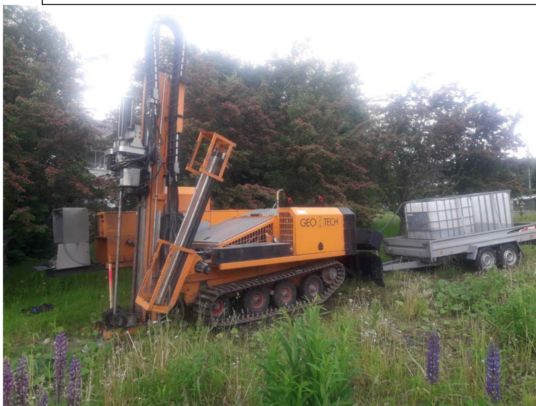
Bilde fra grunnboring 18.06.19
