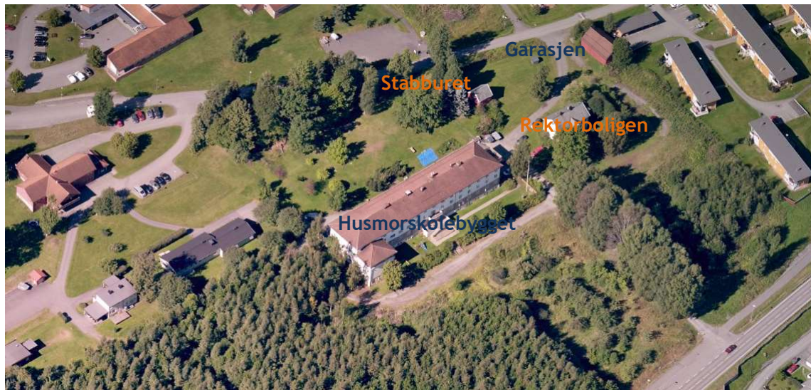
Figur 16: Bildet viser eksisterende bygg på tomten. Husmorskolebygget er revet, og garasjen er det også gitt tillatelse til å rive.
