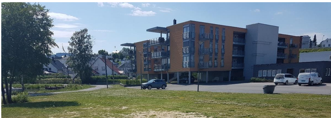
Figur 22 Flerfamiljshus söder om butiken Heidenreich på Huntonstranda. Liknande hus, på pålar, kan vara lämpliga att anlägga på Huntonstranda. Luftspalten mellan markytan och byggnadens bottenyta gör att gas späds ut i luften och har mindre risk att ta sig in i byggnaden.
