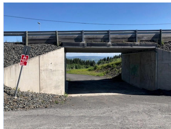
Figur 18: Strekning 3. Kulvert for konfliktfri kryssing av Vestre Totenveg. (foto: ANKRådgivning)
