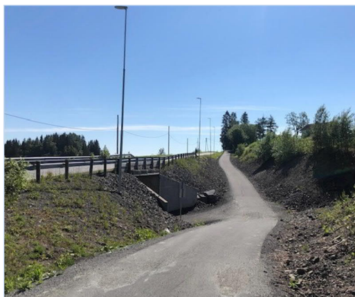
Figur 18: Strekning 3. Kulvert for konfliktfri kryssing av Vestre Totenveg. (foto: ANKRådgivning)
