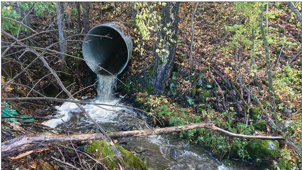
Figur 16. Funksjon for fisk er redusert i Finstadbekken pr. i dag grunnet vandringshinder oppstrøms.
