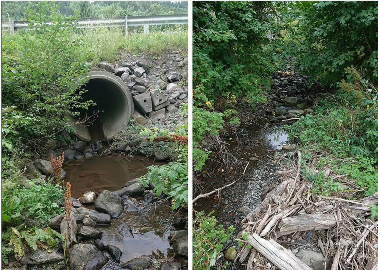
Figur 35. Bulungsbekken går i stikkrenne under dagens E6.
