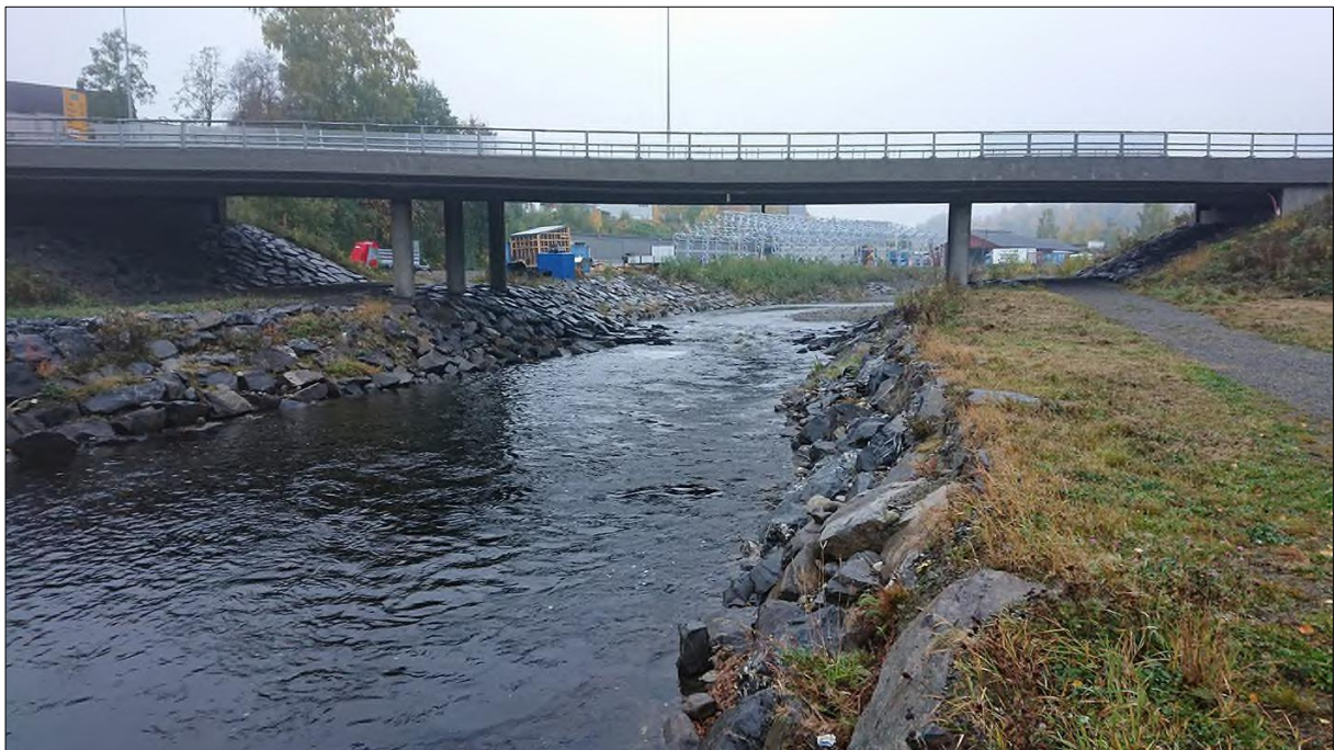
Figur 29. Nedre del av Rinda med dagens E6-krysning er sterkt preget av flomsikringstiltak.
