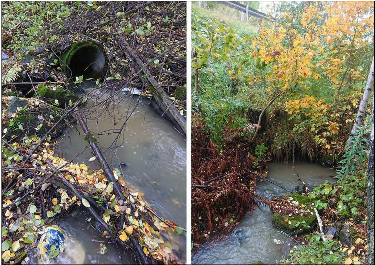
Figur 23. Iversbekken går i stikkrenne under dagens E6.
