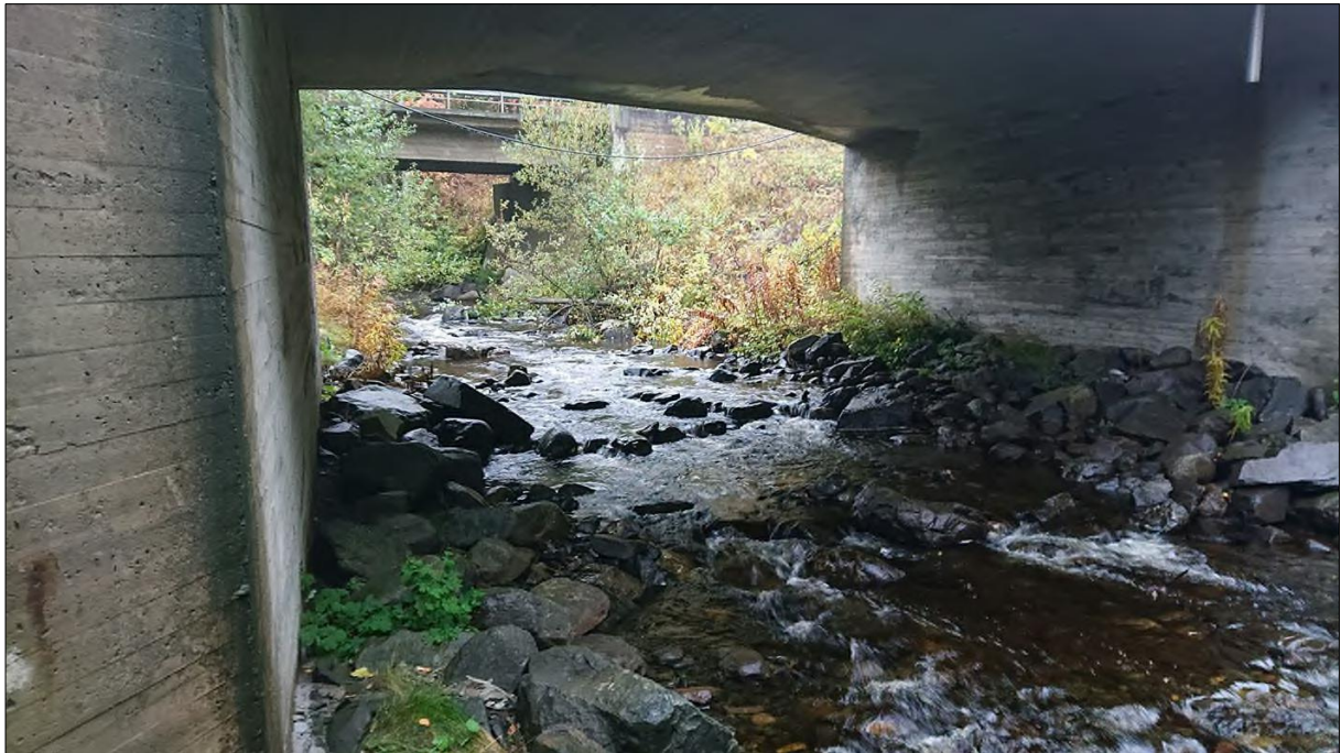
Figur 25. Dagens E6-kryssing over Bjørnstadelva.
