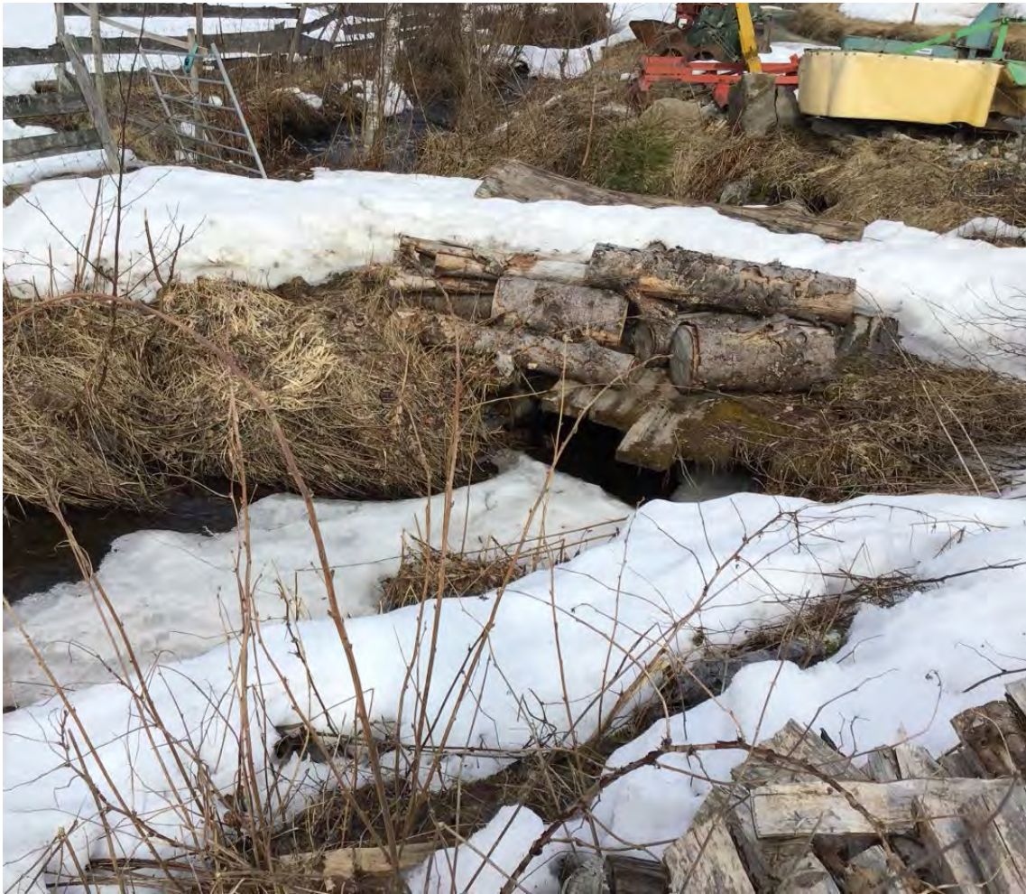
Figur 25 Kulvert 6. Liten bru med bredde på 1,2 meter.
