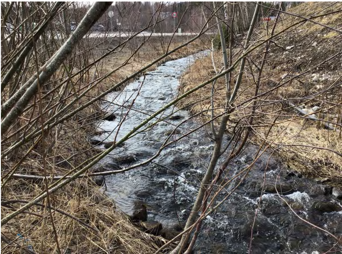
Figur 21 Kulvert 2 - (0,8 og 1,0 meter). Innløp og utløp, og oppstrøms innløp
