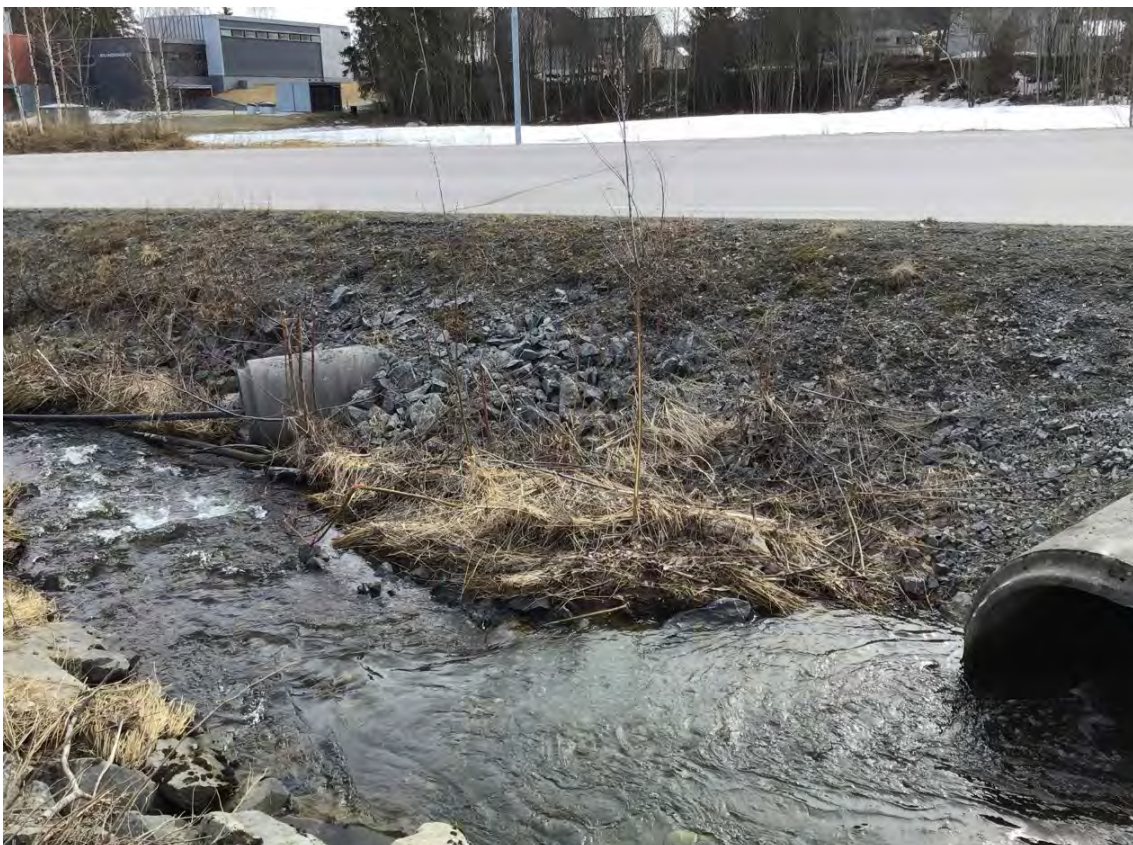
Figur 22 Kulvert 3 (1,0 meter og 0,6 meter)
