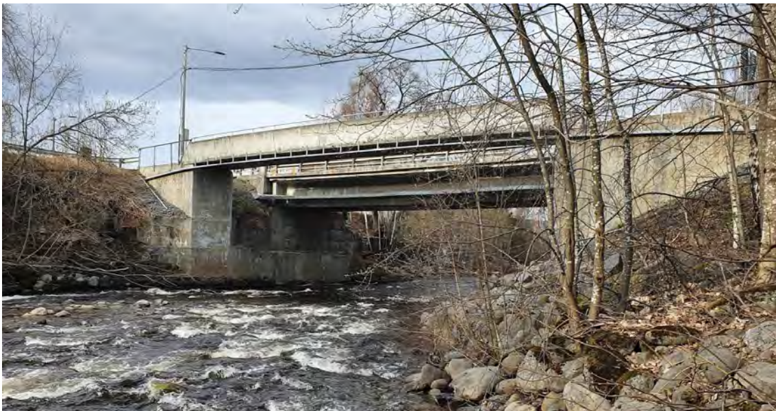
Figur 18 Bro Fv167 Vismunda, Bilde fra oppstrøms side.
