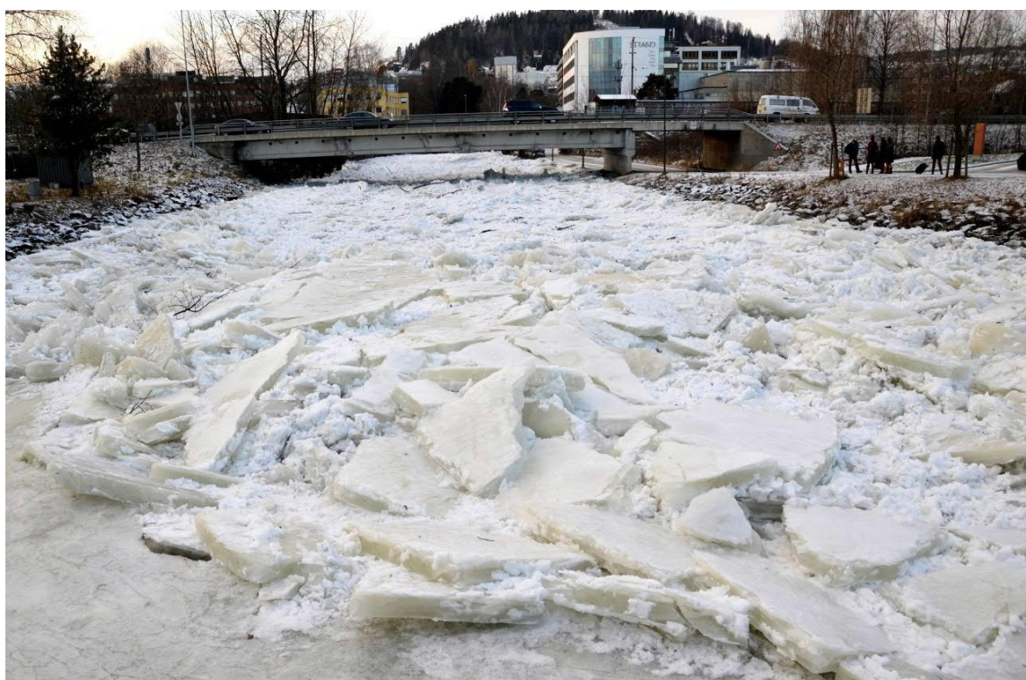
Figur 12: Bru på Lillehammervegen (under isgangen desember 2012) sett fra nedstrøms: Foto: Øyvind Lien kilde ( https://www.oa.no/bildesamlinger/bildeserie-isingang-i-hunnselva/g/1-81-6383795 )
