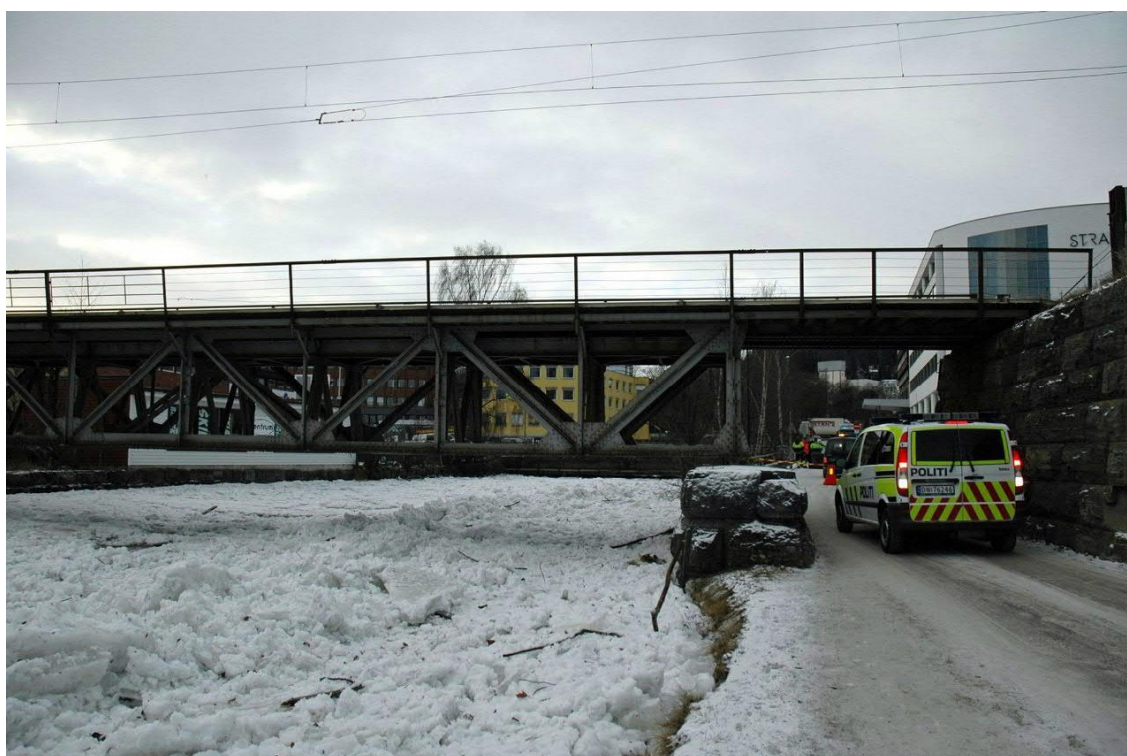
Figur 10: Jernbanebrua (under isgangen desember 2012) sett fra nedstrøms Foto: Øyvind Lien; kilde ( https://www.oa.no/nyheter/gigantisk-ispropp-i-hunnselva/s/1-81-6383372 )
