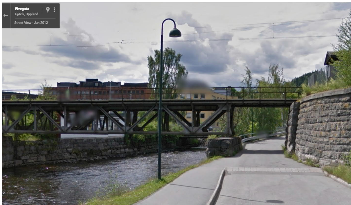
Figur 9: Jernbanebrua sett fra nedstrøms (normalsituasjon): Foto: google Streetview bilde tatt juni 2012
