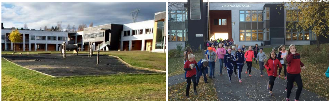
Figur 27 og 28: Bildene viser bygning og deler av uteareal ved Vindingstad skole ( www.aa.no , www.forut.no ).
