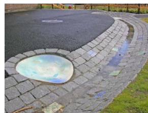
Figur 5: (A) Tverrsnitt av åpen kanal. (B) Et eksempel på hvordan en åpen kanal kan utformes ved skolen med permeable belegningsstein.
