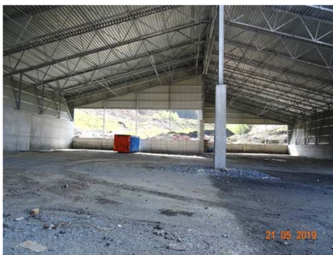
Figur 3. Omlastingshall før etablering av gulv
