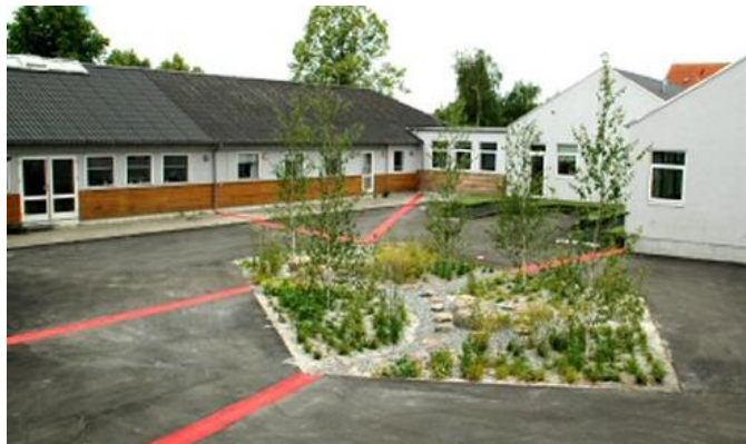
Bilde: Etablering av regnbed i midten av Brøndbyøster skolegård. Her tilkoblet tagvann. Kan også tilkobles vannpost/vannpumpe for at vande planterne (bilde under).
