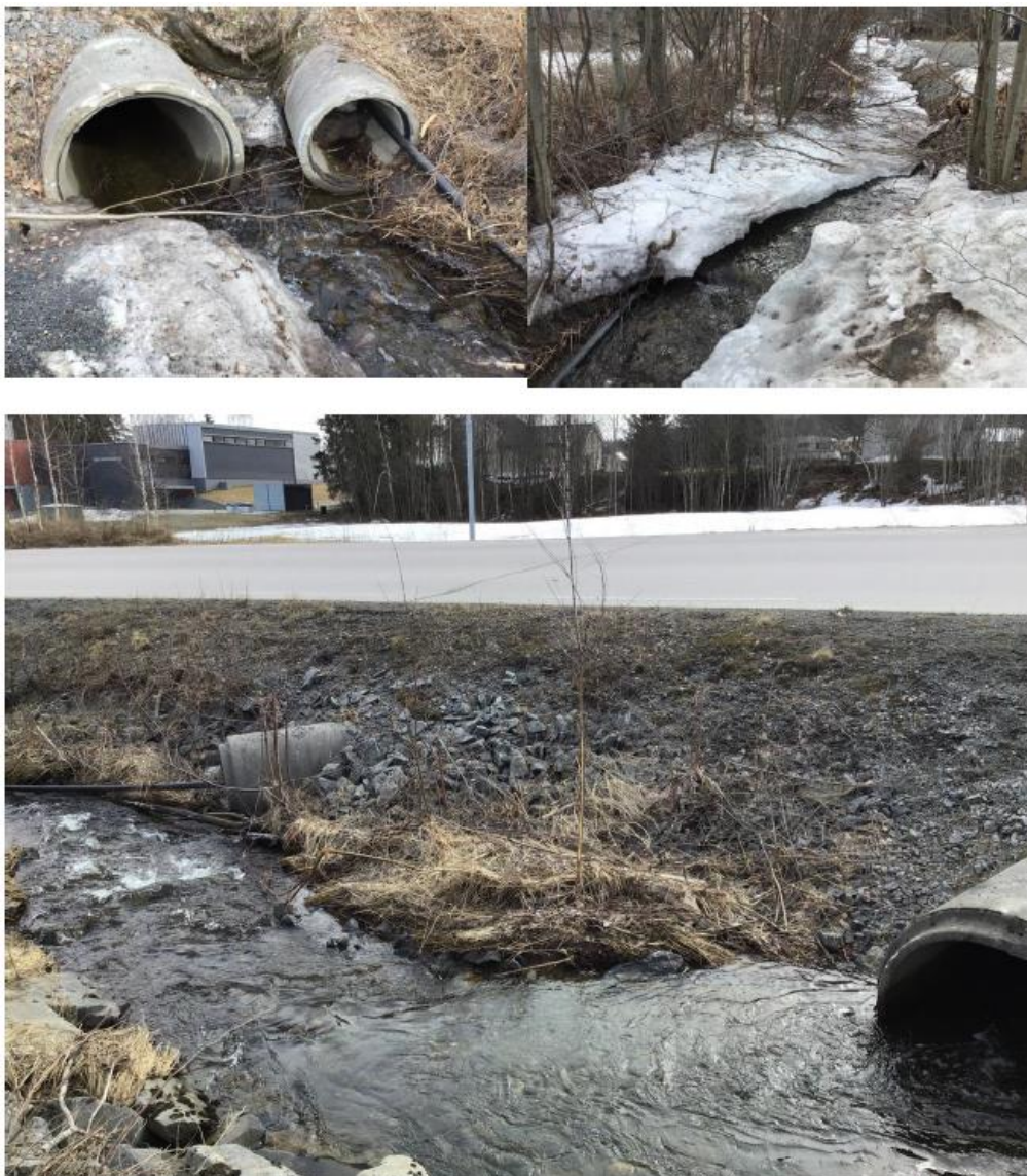
Figur 8: Kulvert ved utløp fra Brynstadbergbekken (topp bilder) til Kragebergbekken (diameter 1m og 0,6 m) (Sweco, 2021).
