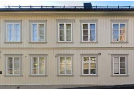
Horizontal oppdeling og vindusrepetisjon i Skolegata 2
