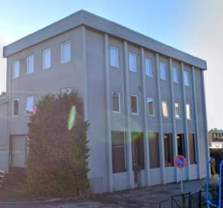
Vertikal oppdeling i Kringens gate 5
