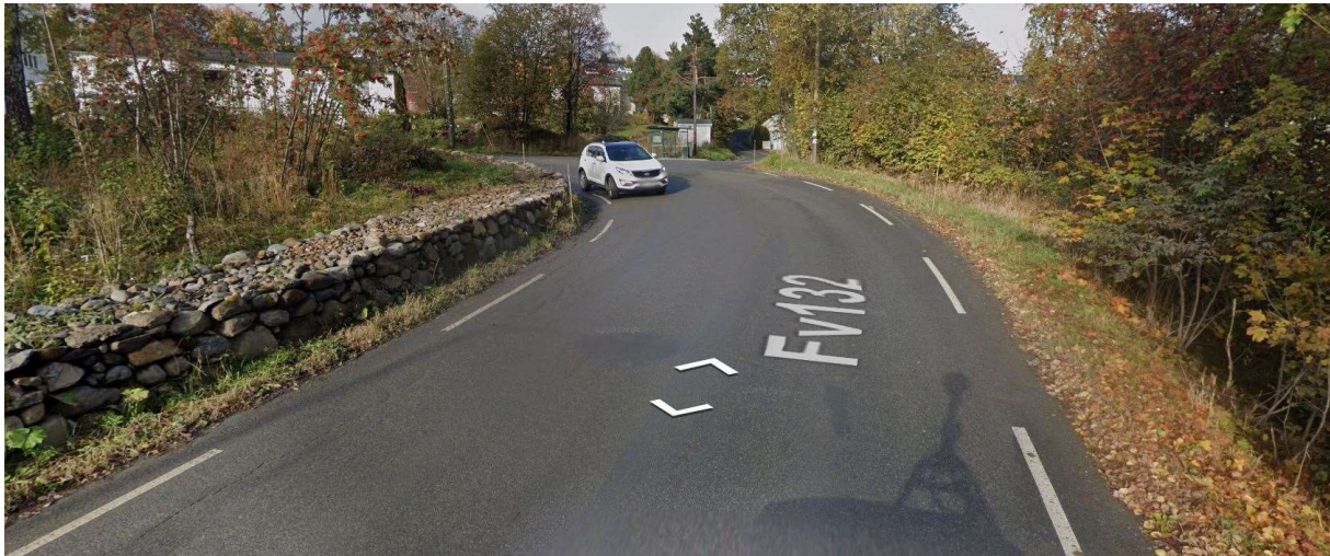
Eksisterende situasjon, Parksvingen. Natursteinsmur og krapp sving. Foto: Google Maps - vis vegreferanse (jolsqard.com)
