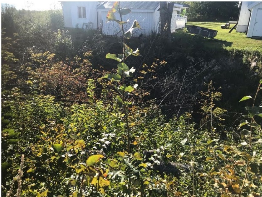
Figur 23. Bilde av bekk.
