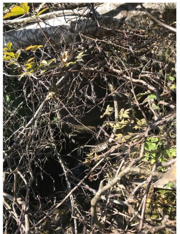
Figur 18. Utløp stikkrenne under FV 2370. DN 900
