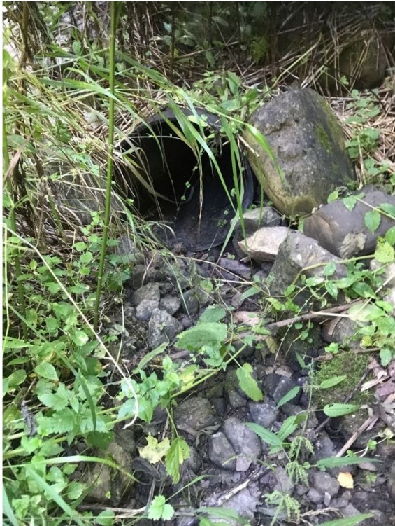
Figur 19. Innløp stikkrenne under Helgerudvegen. DN 420
