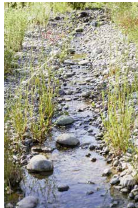
Overvann renner ut gjennom nedsenka grøntområde
