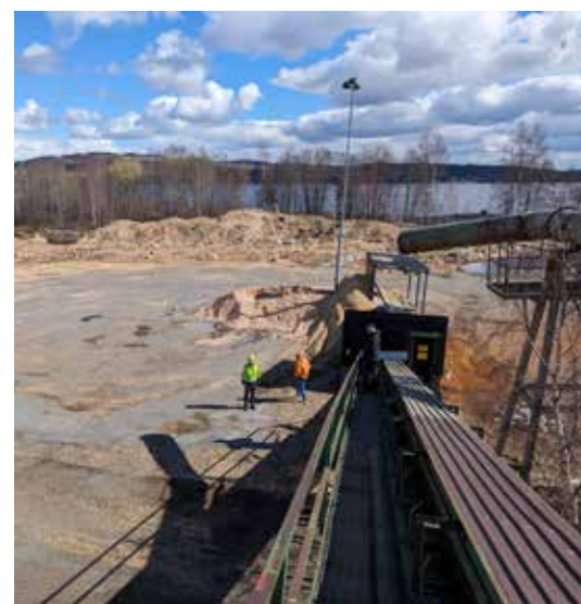
Transportbåndet ved Hunton bevares. Foto: Gjøvik kommune
