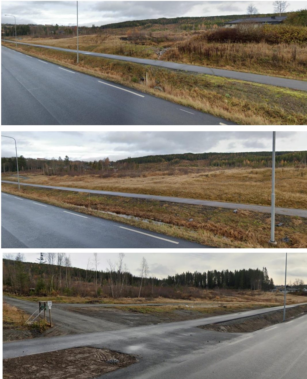
Figur 5: Planområdet per oktober 2022. Den sørlige bekken med stikkrenne; grøften mellom gang og sykkelvei; og dagens innkjørsel mot eksisterende boliger.
