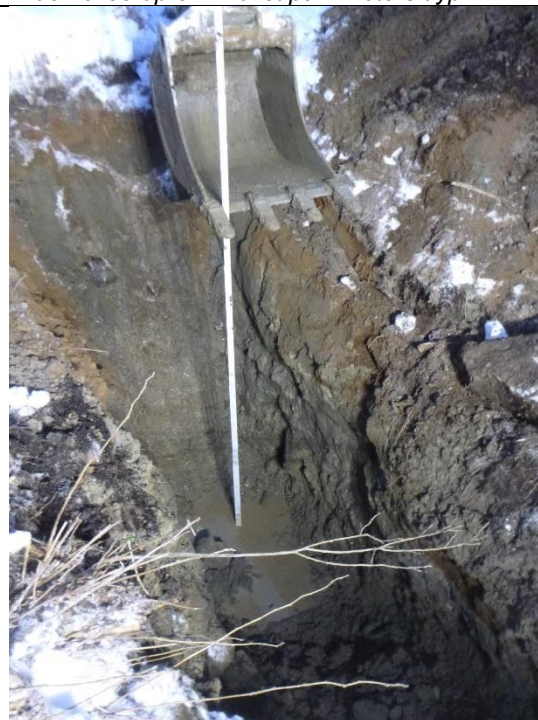
Bilde 27: Måling av hull ved stopp i fjell.
