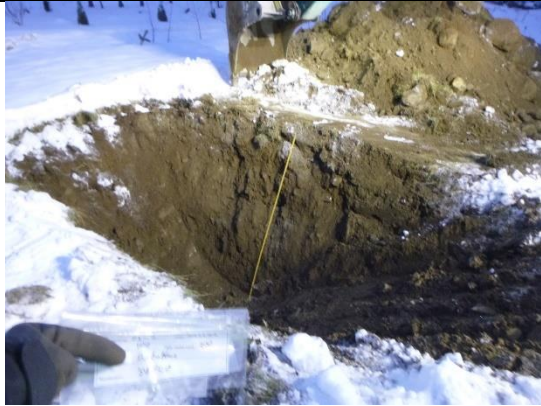
Bilde 3: Jordprofil i hullet på 2 meters dyp
