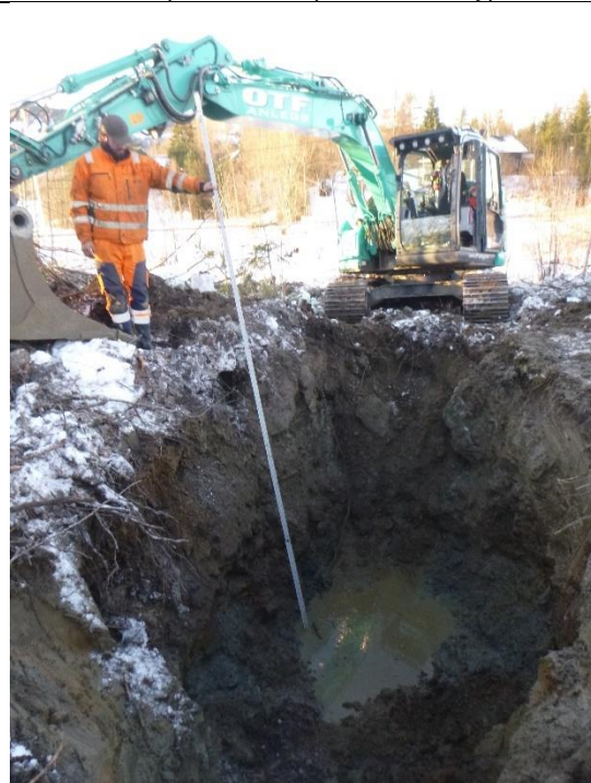
Bilde 46: Måling av hull ved stopp i fjell.
