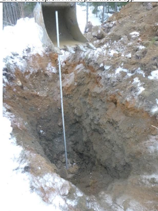
Bilde 18: Måling av hull ved gravestans.
