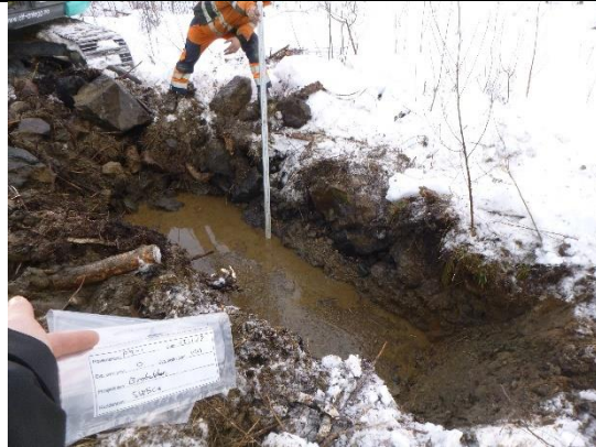
Bilde 37. Jordprofil i hullet på 1 meters dyp
