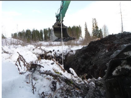
Bilde 13: Måling av dybden på hullet ved påtreff av fjell
