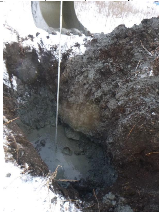
Bilde 39. Måling av hull ved stopp i fjell.
