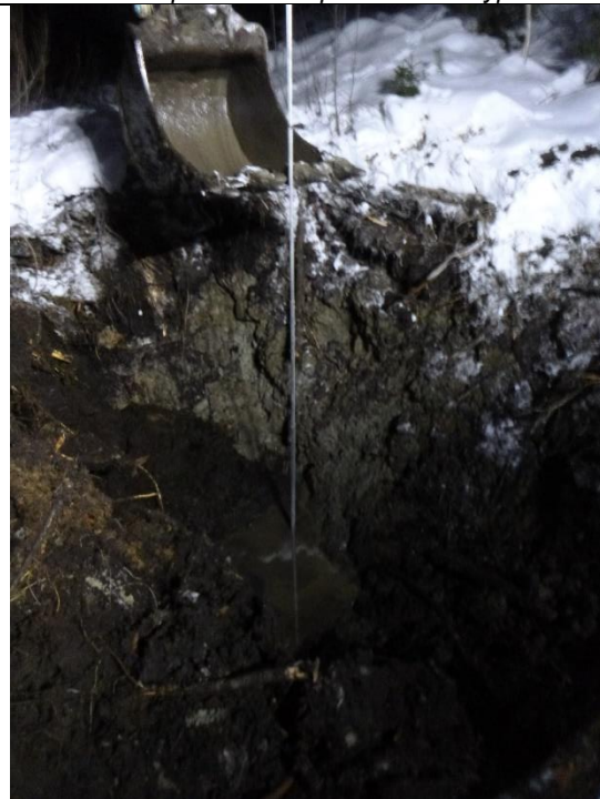
Bilde 31: Måling av hull ved stopp i fjell.
