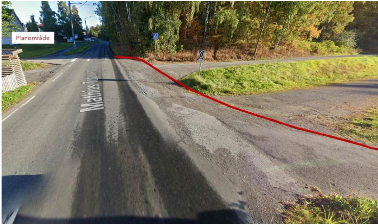
Figur 2-4: Ikke fullstendig etablert gang- og sykkeltilbud mellom undergangen under Raufossvegen og gangfeltet over Mathias Topps veg. (Kartgrunnlag: google.no/maps).
