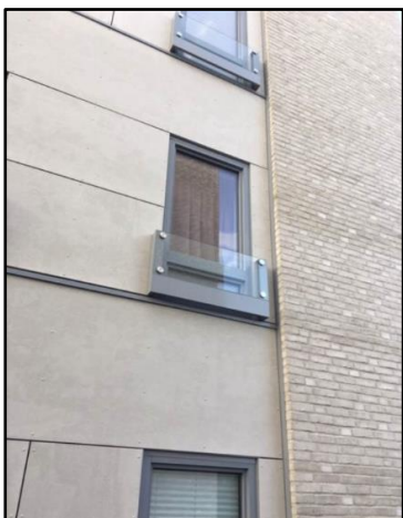
Figur 4-4: Glassfelt som skjermer den åpningsbare delen av et vindu.
